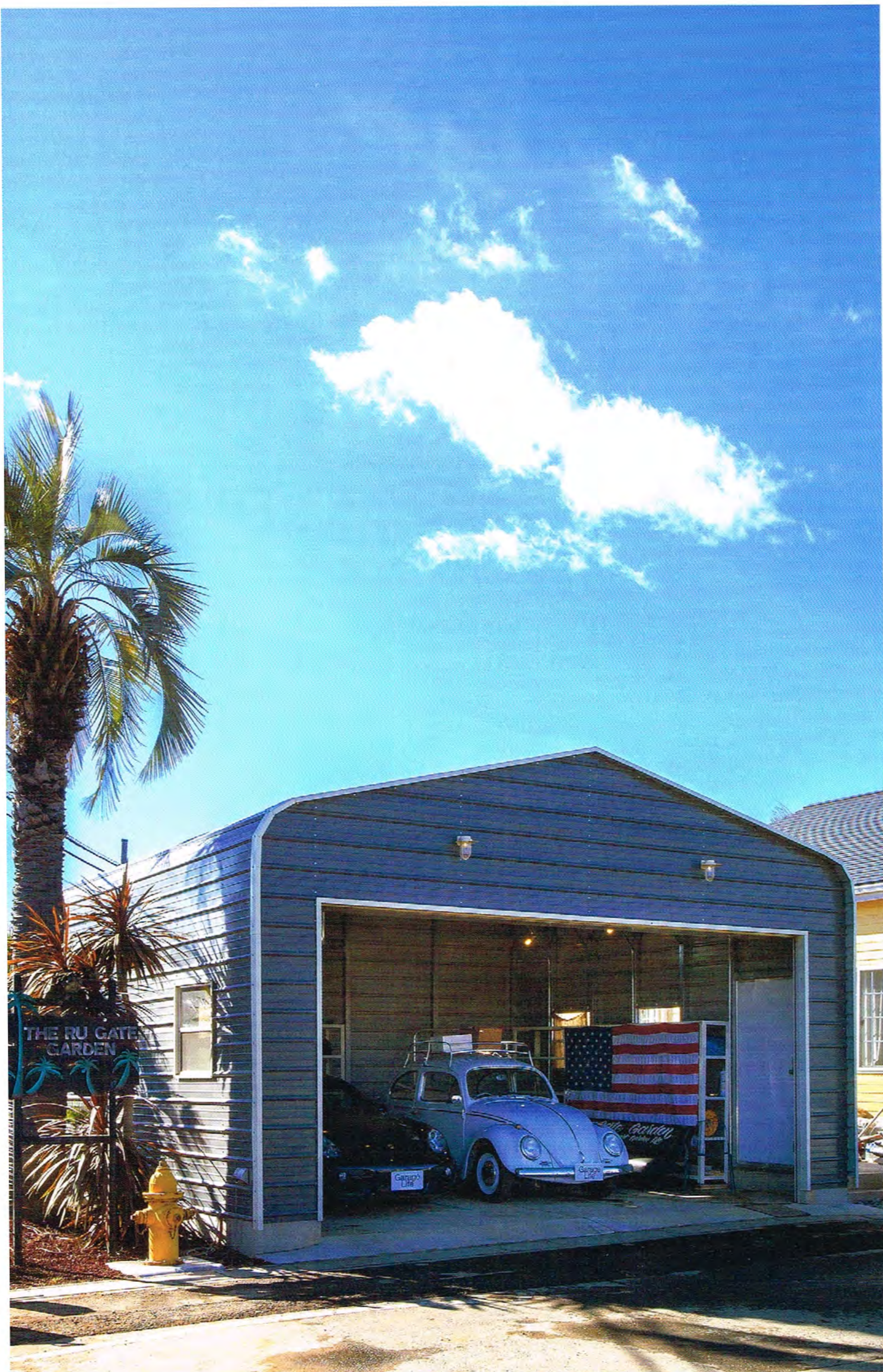
広大な敷地のなかに建てられたアメリカン・スチールガレージ。株式会社「ガレージライフ」の手によって建てられた。
