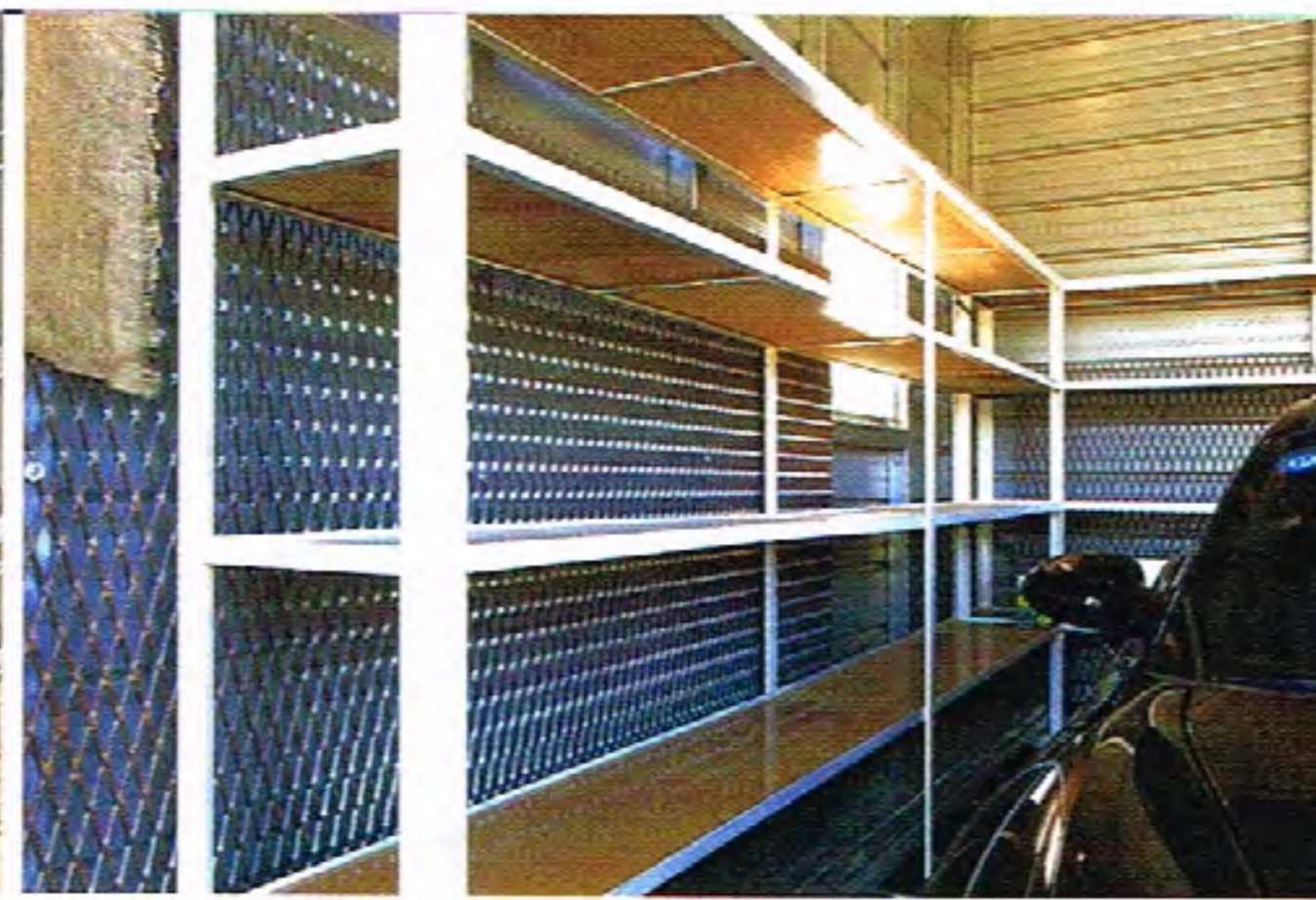
ガレージに農耕機を入れ、接触しても穴が開かないようにと補強もかねてパネル棚を設置。ガレージのスタイルに合わせて、かつアクセントにもなっている。
